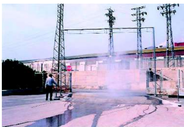
Centro Desinfección en Fuertes,S.A.
